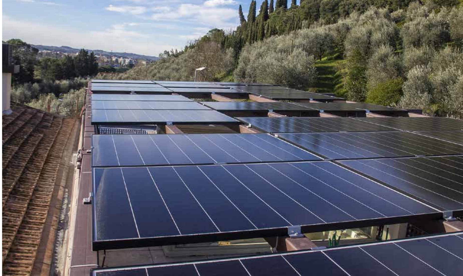
Impianto fotovoltaico 15 kW realizzato su struttura in copertura metallica realizzata su misura
