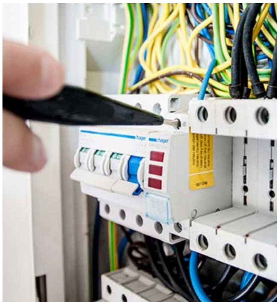
Realizzazione di impianti elettrici e quadri di sezionamento delle linee
