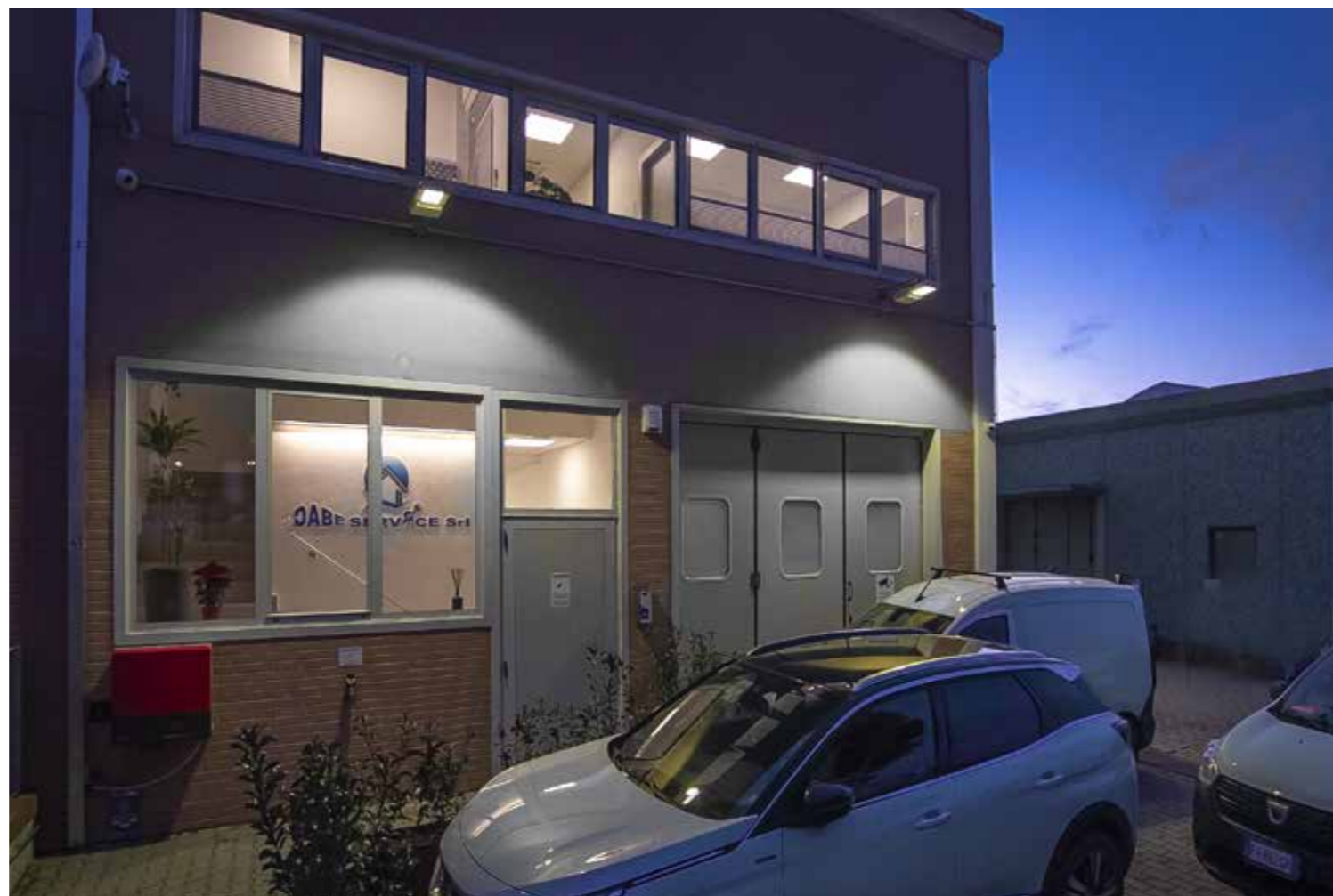
Ingresso principale della nuova sede in località Olmo 115/Q - Reggello
