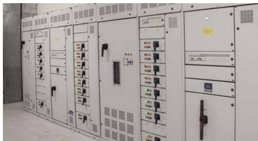
Distribuzione energia elettrica quadri di MT
